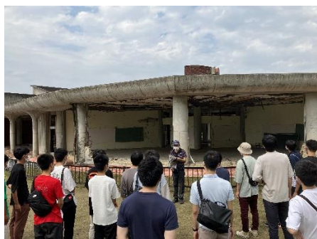
津波によって壊された校舎
